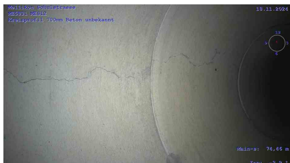
ME5831-MES12_da46d358-380f-45f6-b6da-8caa18714d61_2 0241118_113751_902.jpg, 00:08:34, 74.45m Riss, längs bei 12 Uhr, Start
