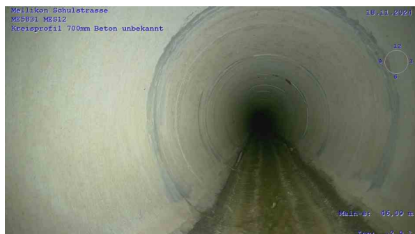
ME5831-MES12_97f7a516-736b-4b14-8c83-fe948f07d956_20241118_113307_100.jpg, 00:04:54, 46.09m Riss, längs bei 12 Uhr, Ende
