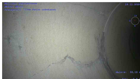
ME5831-MES12_e3a353cb-2a01-4843-8871-e736c20ca481_20241118_113357_109.jpg, 00:05:21, 52.12m Riss, längs bei 12 Uhr, Start
