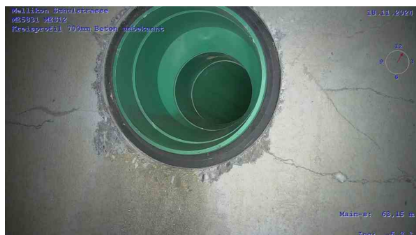
ME5831-MES12_5411aebc-1597-40ac-b995-d9db0a22395f_2 0241118_113600_847.jpg, 00:07:07, 63.04m Anschluss gebohrt, offen bei 1 Uhr
