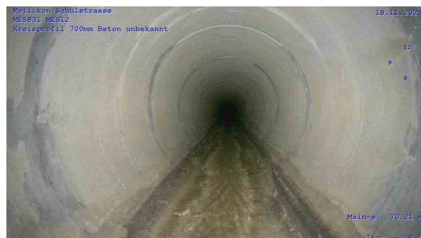
ME5831-MES12_f6cb63f7-4364-4266-bf80-4bdad9fd5c77_20 241118_113712_214.jpg, 00:08:12, 70.21m Riss, längs bei 11 Uhr, Ende
