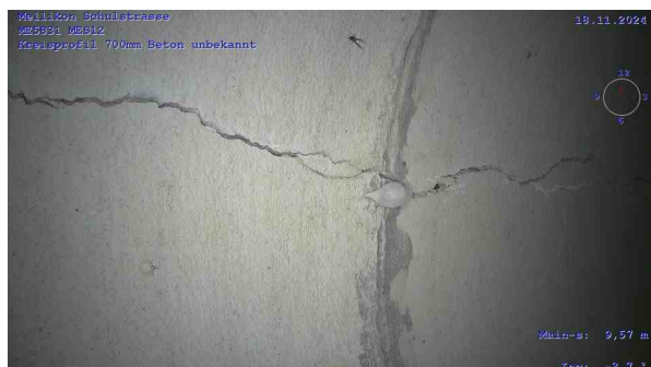
ME5831-MES12_b2e8613b-0d73-488d-be44-d09aec8c07c1_ 20241118_112847_618.jpg, 00:01:19, 9.57m Riss, längs bei 12 Uhr, Start
