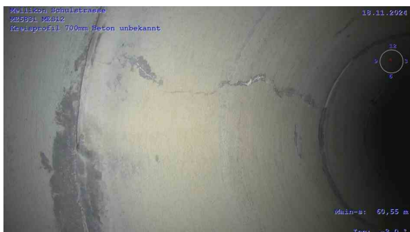
ME5831-MES12_53294486-54cd-4282-8fcf-67b4a82ca5d1_2 0241118_113523_331.jpg, 00:06:38, 60.56m Riss, längs bei 11 Uhr, Start
