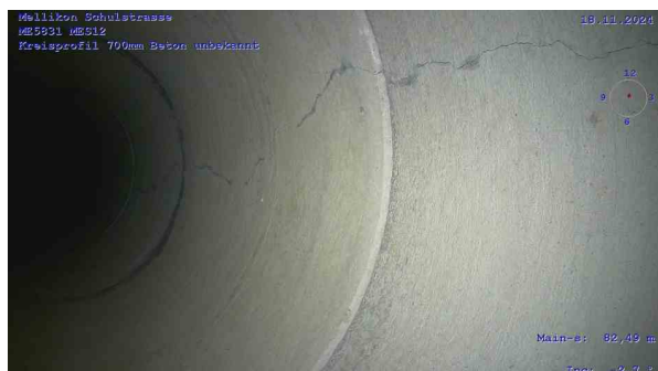
ME5831-MES12_74556df8-c8e0-4d28-9adf-13324d739c8a_2 0241118_113908_534.jpg, 00:09:29, 82.49m Riss, längs bei 12 Uhr, Start
