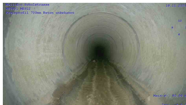
ME5831-MES12_9cfda856-f828-4262-a965-a1748868b536_2 0241118_113834_430.jpg, 00:09:12, 80.57m Riss, längs bei 12 Uhr, Ende
