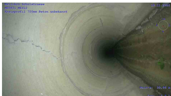
ME5831-MES12_0f69e68b-750d-4035-98ea-4bccee3c1320_20241118_113115_292.jpg, 00:02:50, 22.86m Riss, längs bei 12 Uhr, Start
