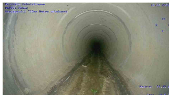
ME5831-MES12_58b2db08-652b-46fd-9427-cc4377f68cd3_2 0241118_113441_707.jpg, 00:06:13, 56.39m Riss, längs bei 12 Uhr, Ende
