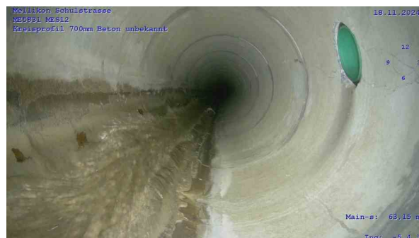
ME5831-MES12_9110660e-8675-4778-b6e1-8eb791afd6cb_2 0241118_113613_463.jpg, 00:07:07, 63.04m Anschluss gebohrt, offen bei 1 Uhr
