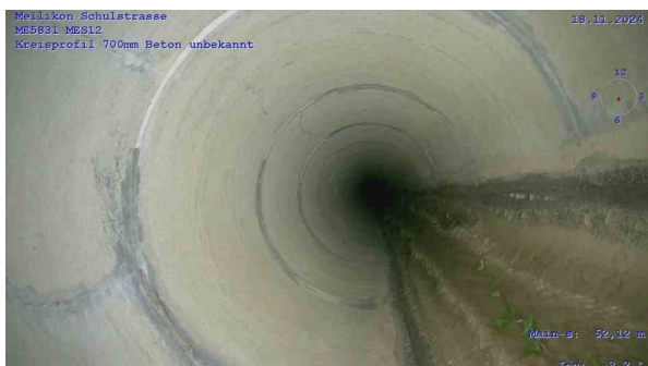
ME5831-MES12_6c5ccc3b-6e68-4e9d-9f94-fad85e81c79d_2 0241118_113403_679.jpg, 00:05:21, 52.12m Riss, längs bei 12 Uhr, Start
