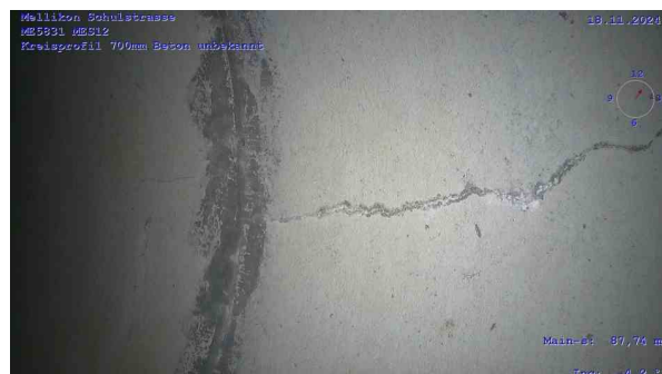
ME5831-MES12_ac3b9636-c1d5-4635-b94b-e9f7dfbc6e4e_2 0241118_113956_738.jpg, 00:10:10, 87.73m Riss, längs bei 12 Uhr, Ende
