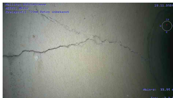
ME5831-MES12_03ee66d3-9964-46dc-8934-7cef5b5d520d_20241118_113109_056.jpg, 00:02:50, 22.86m Riss, längs bei 12 Uhr, Start
