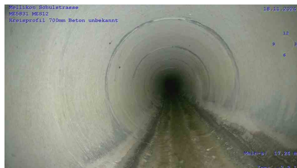
ME5831-MES12_66d8e18e-a71c-41b6-9aec-494d694825a6_ 20241118_113006_257.jpg, 00:02:27, 17.24m Riss, längs bei 12 Uhr, Ende
