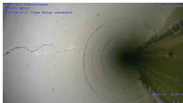
ME5831-MES12_327e6912-3ba9-48aa-bf14-6023da31f50e_2 0241118_112857_896.jpg, 00:01:19, 9.57m Riss, längs bei 12 Uhr, Start
